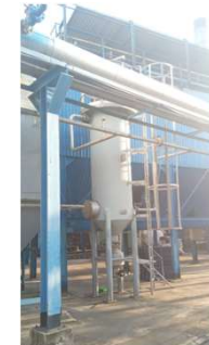
Hệ thống khử khí – để loại bỏ H 2 S
